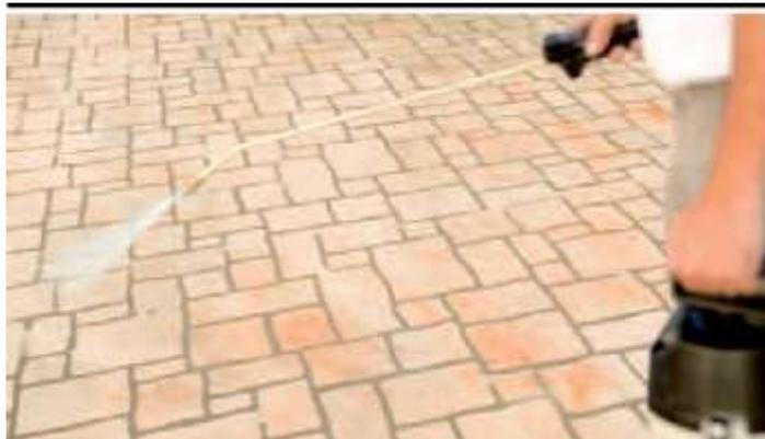
Après avoir retiré la trame, il est impératif de protéger le béton d'une dessiccation trop rapide (risque de fissures) due à l'évaporation de l'eau contenue dans le béton.
