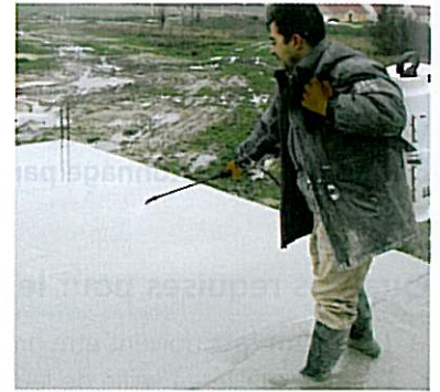
Application d'un produit de cure
