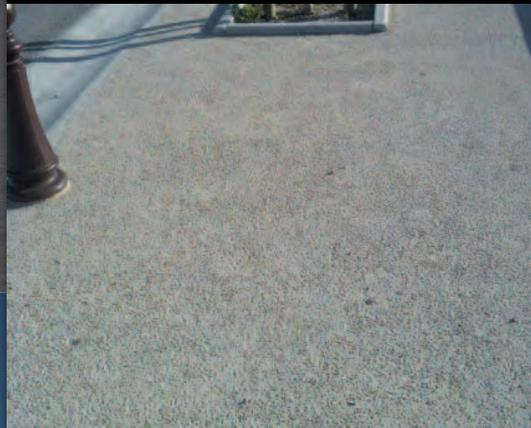
**SOL DESIGN DÉSACTIVÉ** est un procédé de béton hydraulique de formulation spécifique, laissant apparaître les granulats à la surface après un traitement avec un produit désactivant.
